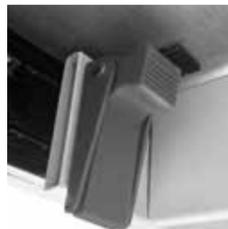
Detalle del freno del sistema de extensión
